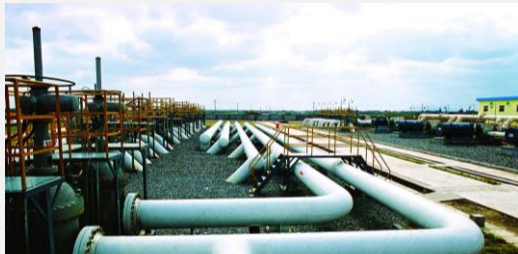
Inspección de Tuberías
